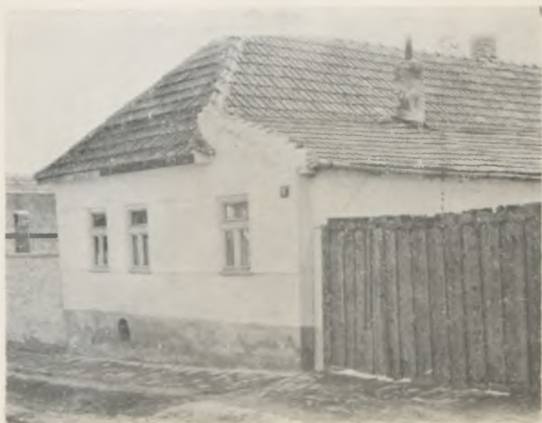
4. tábla — Házak sátoros tetővel — a fenti díszes kapuval, az alsó egyszerű bejárattal, utcai toldalékszobával és harmadik ablakkal.
